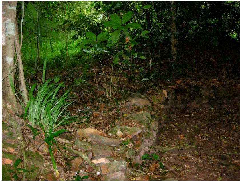
Hình 28: Bờ kè tận dụng gạch thời chúa Nguyễn .
